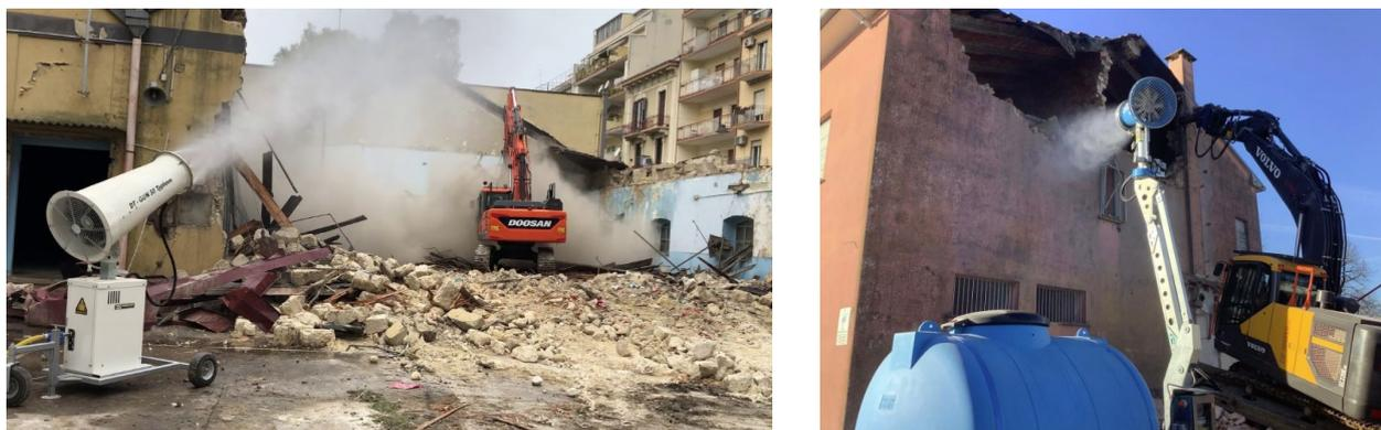
Figura 1: Esempio Fog cannon: posizionamento a terra (sinistra) e in quota (destra)
