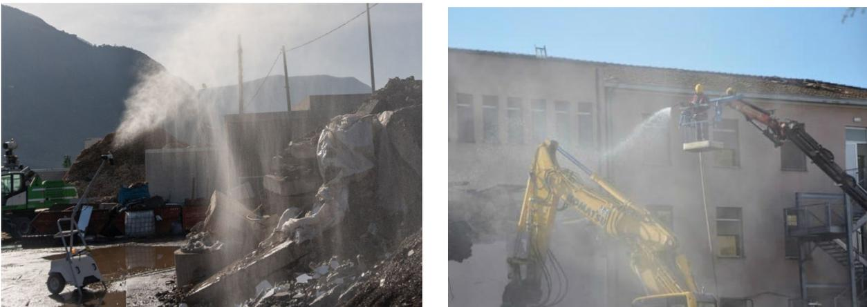
Figura 2: Esempio Lancia nebulizzatrice: posizionamento a terra (sinistra) e in quota con operatore (destra)
